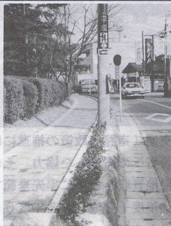
福大東側の歩道完成 ～福大が提供～ 片江五下水工事中 片江五丁目 下水只今工事中
